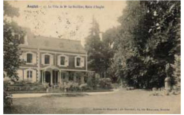
Façade principale Est
